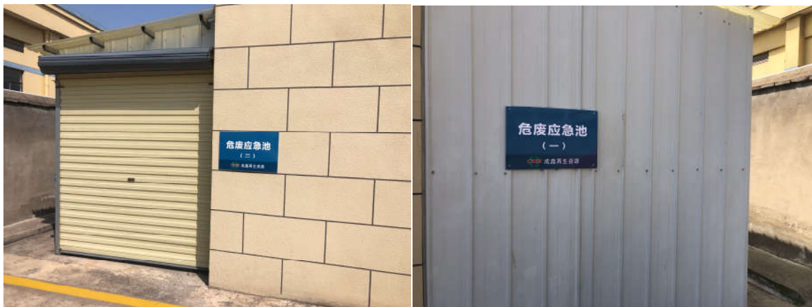
图4-15 废铅酸蓄电池和废矿物油暂存间泄露液应急收集池
