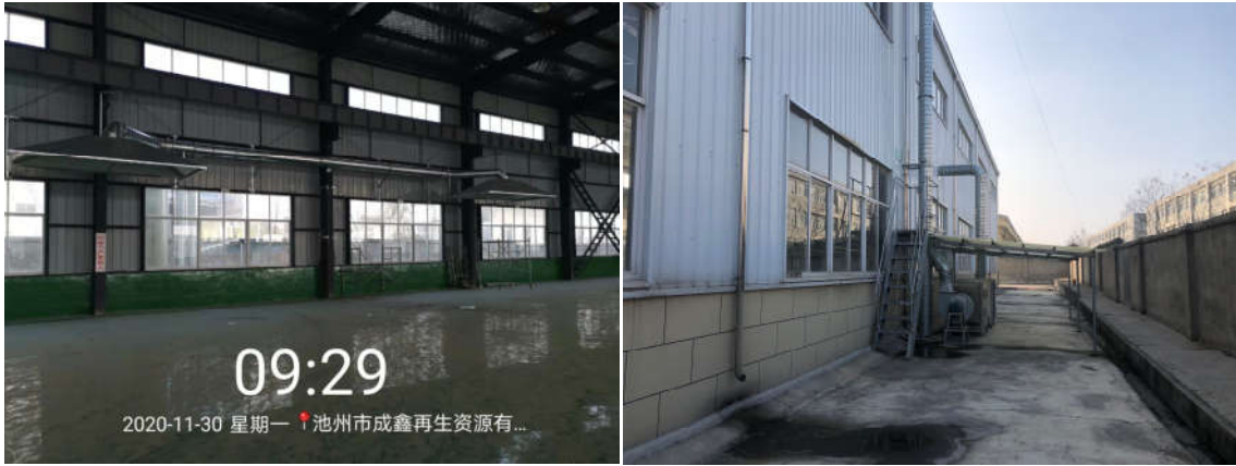
图4-7 预处理车间挥发性有机废气收集处理系统
