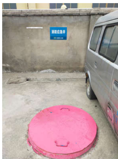
图4-19 地下水监测井
