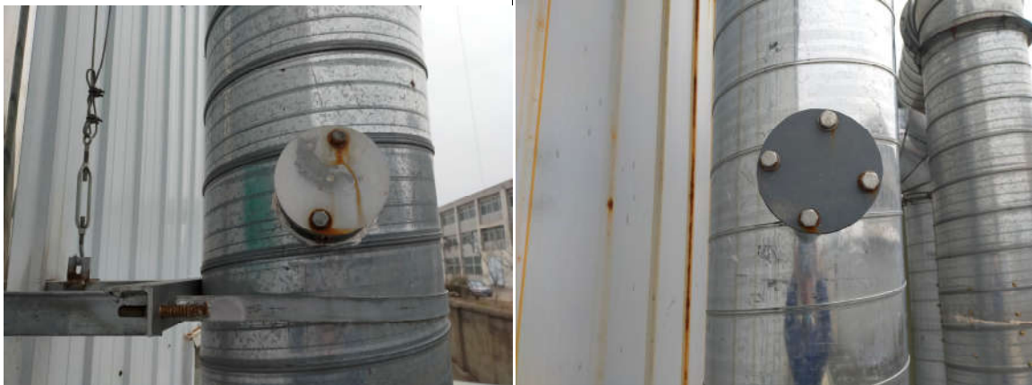
图 4-9 挥发性有机废气和粉尘处理设施监测孔
